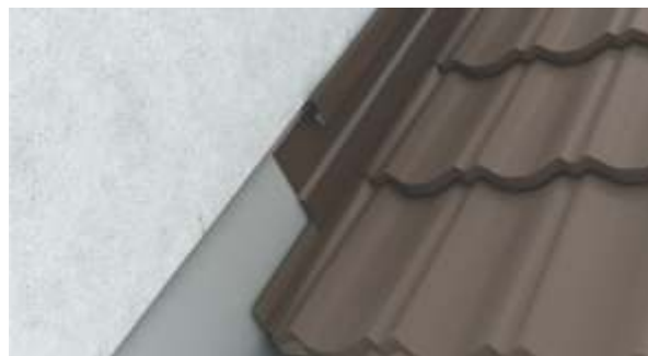
fig. 28 - Montarea elementului de racord la perete. Variantă alternativă
