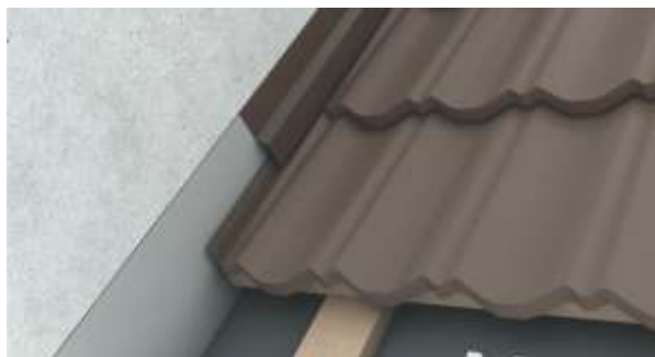
fig. 27 - Montarea elementului de racord la perete
