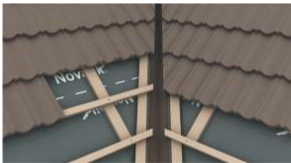
fig. 24 - Montarea și fălțuirea modulelor în dolie
