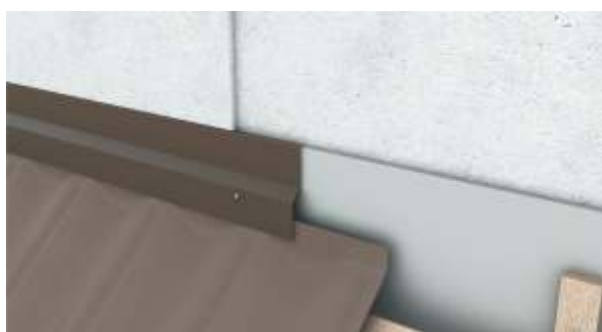
fig. 30 - Montarea elementului de racord pe orizontală
