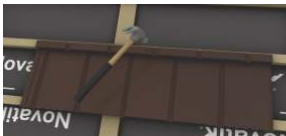
fig. 15a - Fixarea rândului 2 din zona de coamă
